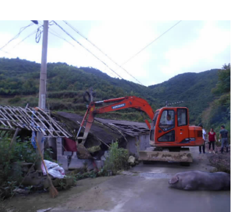
毛必富养猪场整改中
