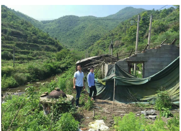
工作人员在养殖场拆除现场
