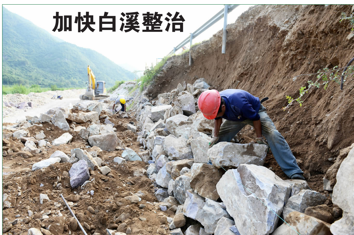
近年来,横渡镇把生态文明建设放在突出的位置,加大力度对白溪进行整治。该工程位于横渡镇白溪村下游,健跳港上游,设计防洪标准10年一遇,该工程总造价为2400万元。本次整治河段总长度5.3公里,修建亲水平台、亲水台阶和5100米游步道,对堰坝进行修复和新建。目前,涉及200多农户的政策处理也已完成,工程已完成总工程量的50%。图为9月24日工程队正在对堰坝进行修复和新建。陈维连 摄
