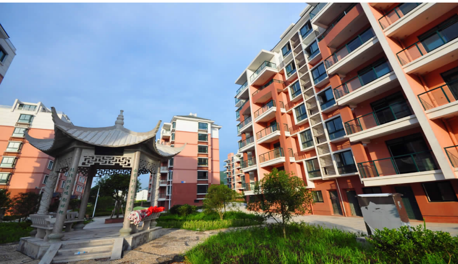
近日,西区经济适用房和廉租房(春晖小区)全面竣工,并完成小区绿化道路工程。图为7月3日上午,记者拍摄的小区一角。
