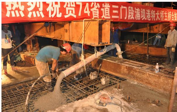
本报讯(记者 吴晓玲)7月3日凌晨,浦坝港特大桥上机声隆隆,亮如白昼,工人们正对大桥主跨合龙部分进行紧张施工。零时30分,15.7立方米的混凝土浇筑完毕,省重点工程74省道南延三门段浦坝港特大桥顺利合龙。
