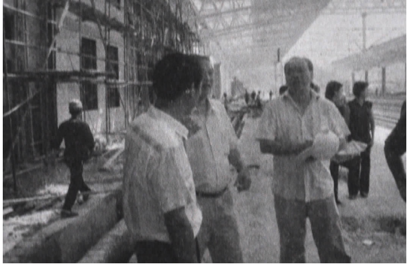
县人大代表视察铁路建设进度
