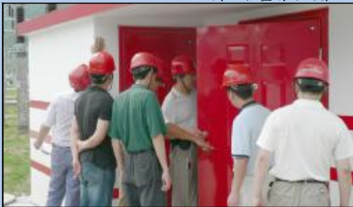
图二:检查消防设备
