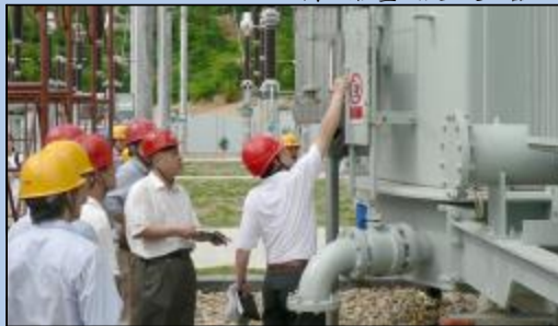
图三:检查1#主变压器
